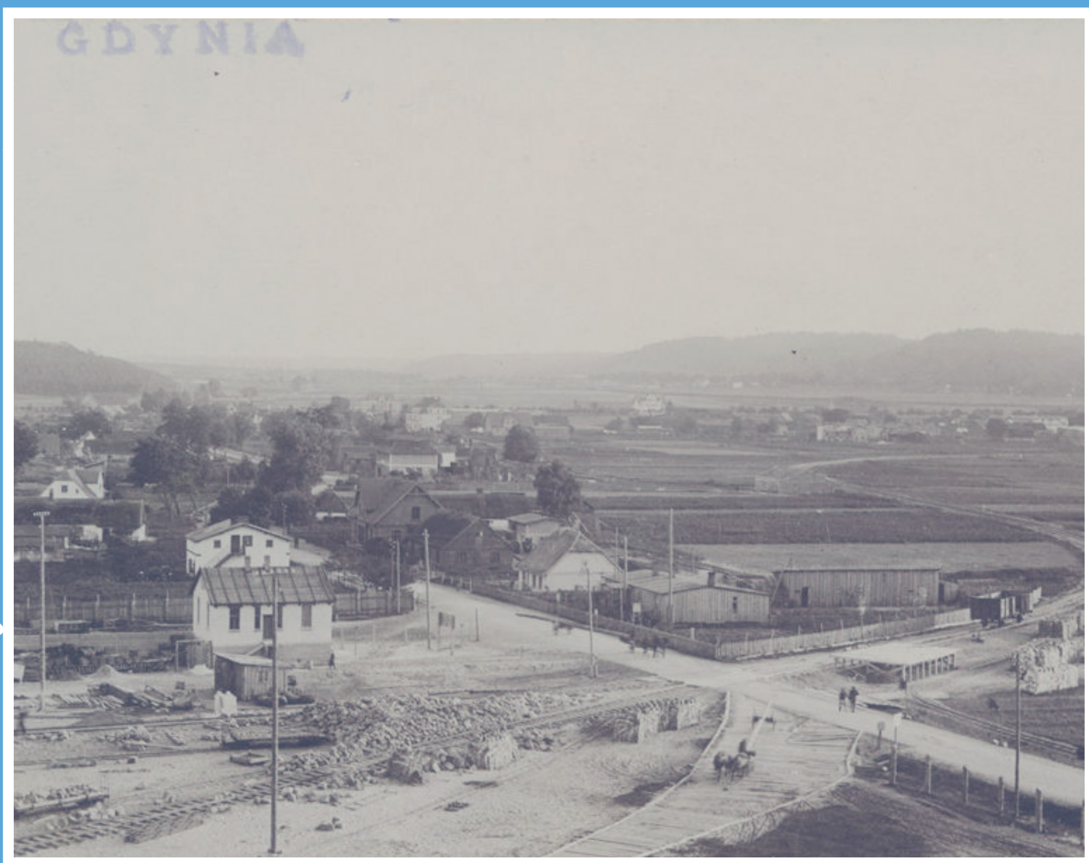
Panorama Gdyni od strony portu w 1924 roku. Widoczna drewniana i murowana zabudowa jeszcze wówczas wsi. Fot. Roman Morawski, zbiory Muzeum Miasta Gdyni.
