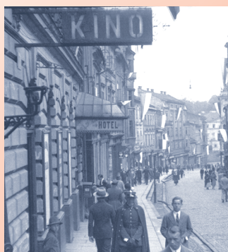
Cieszyn. Ulica Głęboka, źródło: NAC
