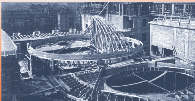
Budowa gmachu Sejmu Śląskiego i Urzędu Wojewódzkiego w Katowicach, źródło: NAC
